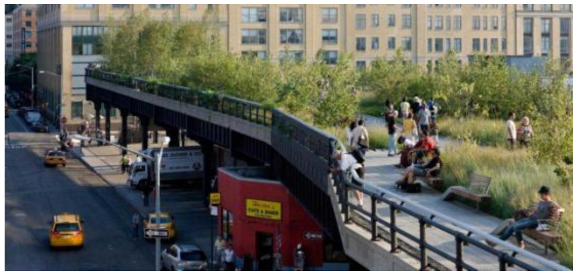
高线公园高架桥改造为游憩设施
